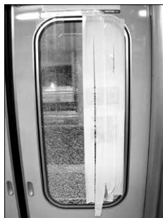
応急処理後の状態
